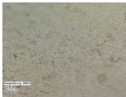
▲ Bild 17 | Schleifspuren durch abrasive Oberflächenreiner
